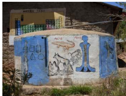
Wasser für die Schule! Dachwasser-Fassung in der Adi Abari Schule in Adwa
