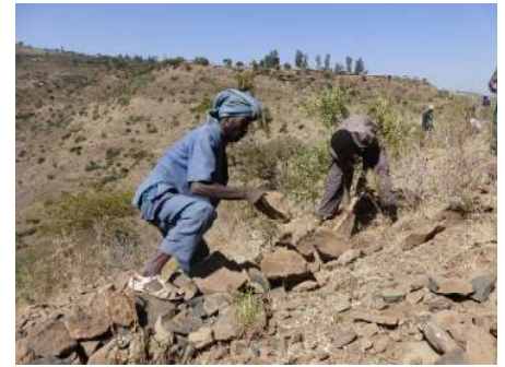
Im Frühjahr wurden hier in Seglem Terrassen gebaut, Wassergräben ausgehoben und Pflanzlöcher gegraben, damit dann in der Regenzeit (Juli-September) wertvolle Waldbäume gepflanzt werden konnten. Diese Bauern leisten mind. 30 Tage Freiwilligenarbeit. Diese unbezahlte Arbeit ist der Beitrag der Bauern zur Projektrealisierung.
