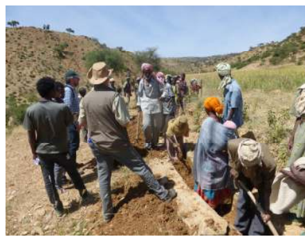
Unterwegs zum Aufforstungsgebiet Adis Alem: Bauern beim Reinigen des Kanals nach der Regenzeit. Dieser Kanal führt Wasser vom Aufforstungsgebiet / Damm zu den Gemüsefeldern
