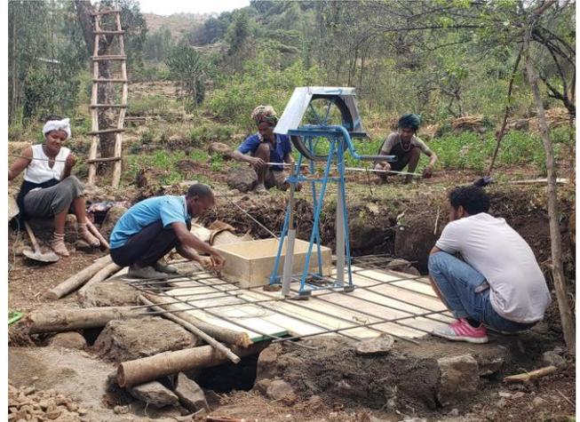
Grâce à l'augmentation du niveau de la nappe phréatique au pied des reboisements, l'eau peut être pompée manuellement à faible profondeur à l'aide de « Rope Water Pumps » et ne doit pas être transportée sur de longues distances à pied avec des bidons.
