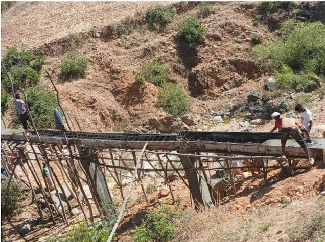
An einem Kanal, der später das Wasser vom Damm zu den Feldern führen wird, haben die Bauarbeiten bereits begonnen. Das Aquädukt überquert einen Graben.
