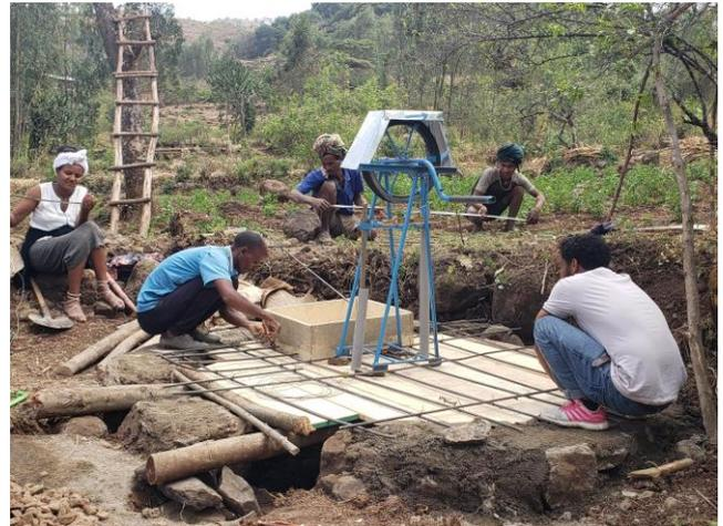
Dank gestiegenem Grundwasser-Spiegel am Fusse von Aufforstungen kann Wasser mit «Rope Water Pumps» aus geringer Tiefe manuell hochgepumpt werden und muss nicht mit Kanistern über lange Fussmärsche getragen werden.
