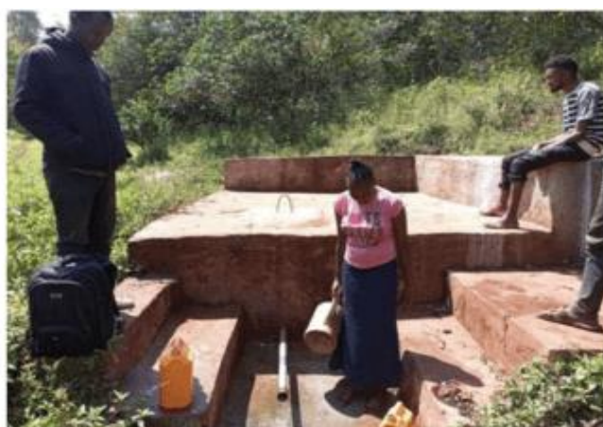
Au pied des montagnes reboisées, l'eau est stockée dans des chambres de captage (une pratique à l'époque très répandue en Suisse, avant que de plus grands réservoirs ne soient construits) et représente ainsi une eau potable fraîche et proprement filtrée, également à disposition pendant la sécheresse
