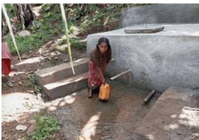
Au pied des montagnes reboisées, l'eau est stockée dans des chambres de captage (une pratique à l'époque très répandue en Suisse, avant que de plus grands réservoirs ne soient construits) et représente ainsi une eau potable fraîche et proprement filtrée, également à disposition pendant la sécheresse
