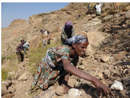
Bau von Terrassen
