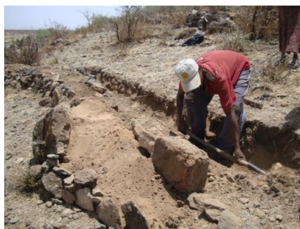
Bau von Erd- und Steinwällen mit Wassergräben
