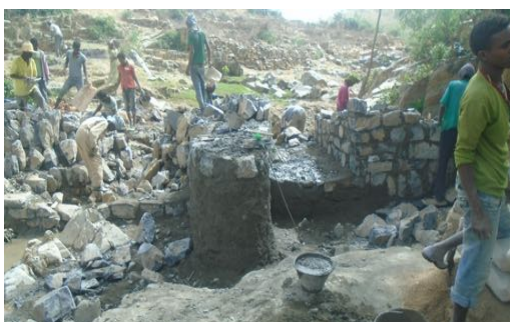
Beginn Bau Egabir Staudamm Adwa, Tigray (Foto von Projektpartner)
