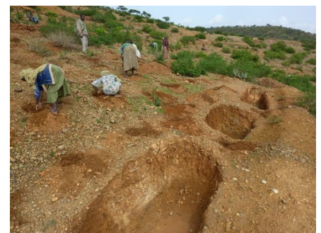
Aushub von Wassergräben
